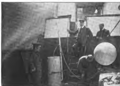
Gasapparat System „Naß“.
